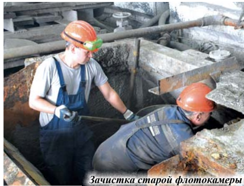
Зачистка старой флотокамеры
