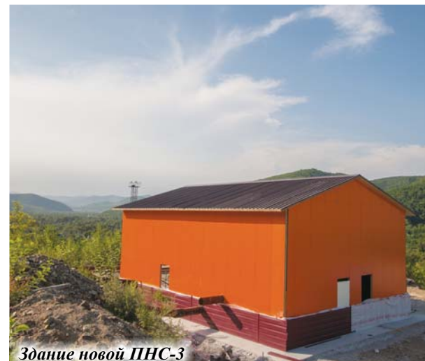
Здание новой ПНС-3
