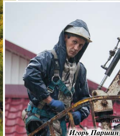
Монтаж новой опоры ВЛ-35кВ
