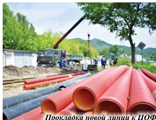
Прокладка новой линии к ЦОФ
